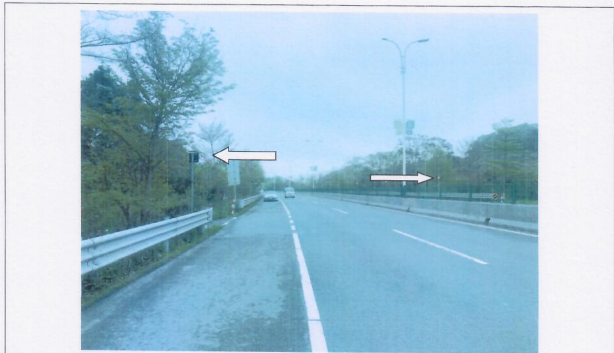
图 1: 上图为复勘事故现场由西往东方向拍照, 可见路面两侧连续爆闪灯及防撞护栏
