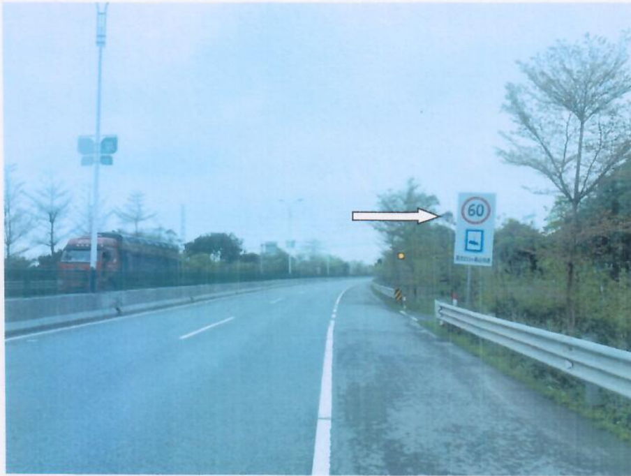
图 2: 上图为复勘事故现场由东往西方向拍照, 可见限速及区间测速标志。
